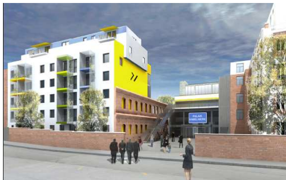
Ansicht Bauplatz Y und Palais Kabelwerk Oswaldgasse
